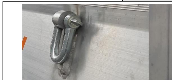
Závesné oko pre vertikálny transport
